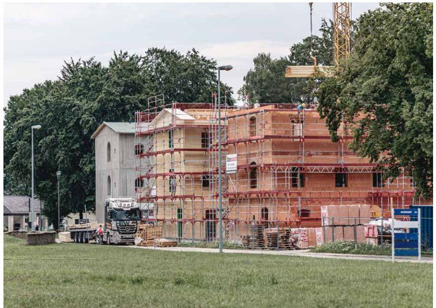
Abbildung 1: Die Forschungshäuser im Bau, Foto: Max Kratzer
