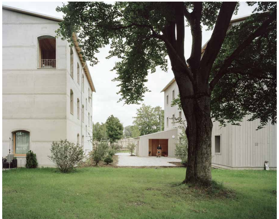
Abbildung 3: Blick in den Hof, links Mauerwerk, rechts Holz-Hybrid Foto: Sebastian Schels, pk Odessa
