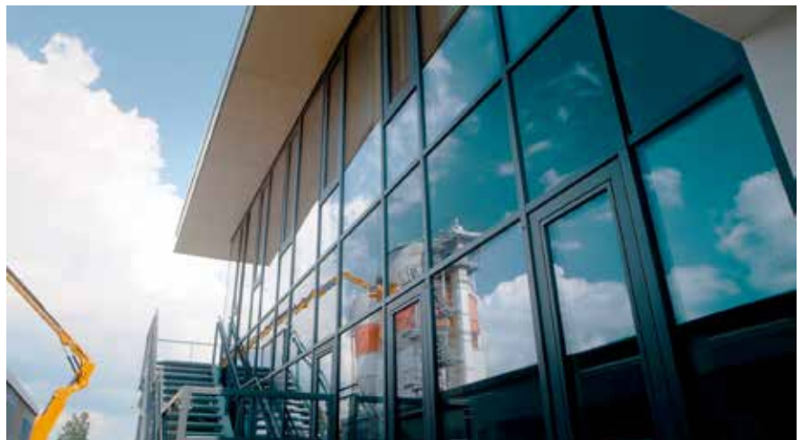
Abbildung 16 Ansicht der Außenfassade
